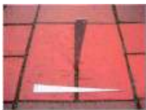
Рисунок 32. Измерение ширины шва при восстановлении покрытия
