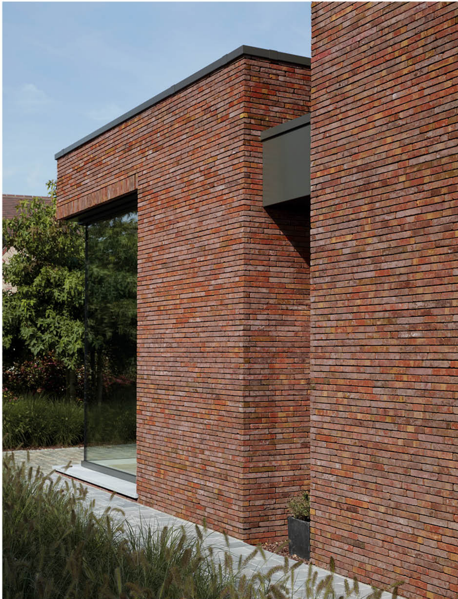
Фасад: Metropolis Aula Rood/ Крыша: Koramic Actua 10 LT Antraciet mat
