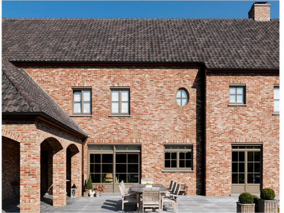
Архитектурное бюро Vincent Deprez, г. Звейвегем
