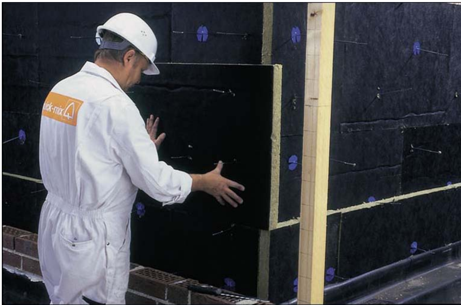
Укладка второго слоя изоляции.
